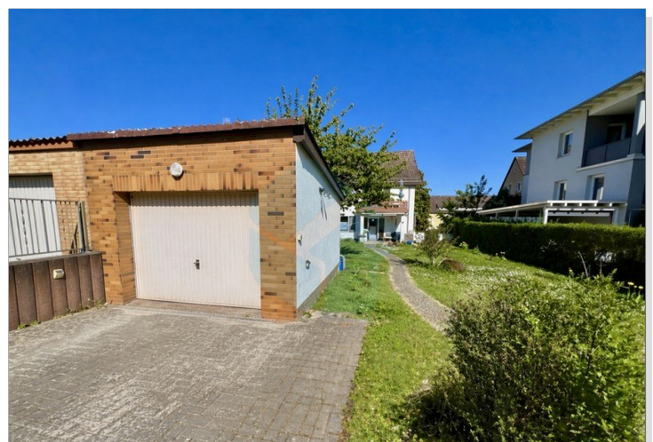
Garagenansicht (Ansicht hinten/Garten)
