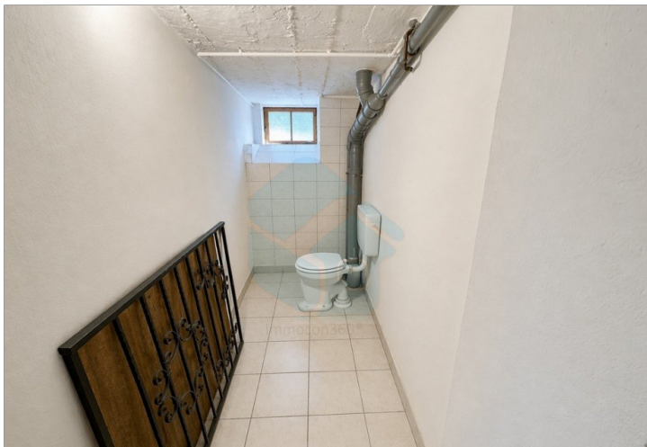
Keller mit Toilette
