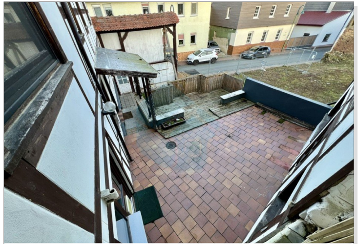
Ansicht zum Innenhof vom OG
